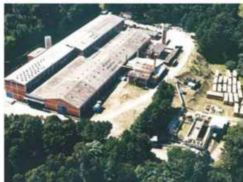
Unidade Industrial - São José dos Pinhais - PR
